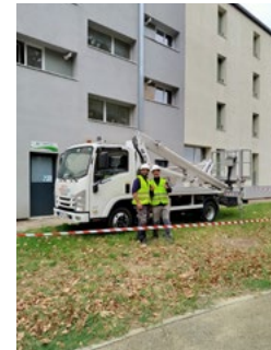
Réparation de chéneau avec camion-nacelle
