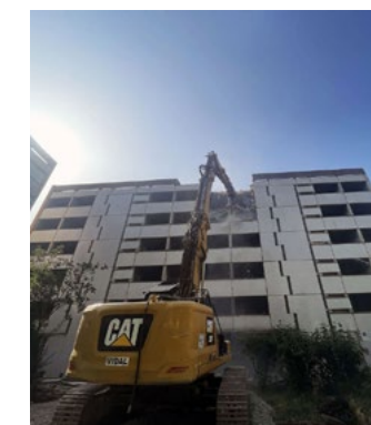
20-24 rue Maréchal Augereau et 34-36 avenue Kellermann Programme ANRU Cantepau Demain ALBI
